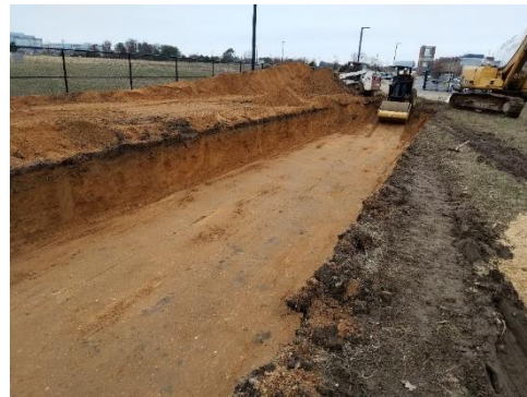
(d) Compaction Process
